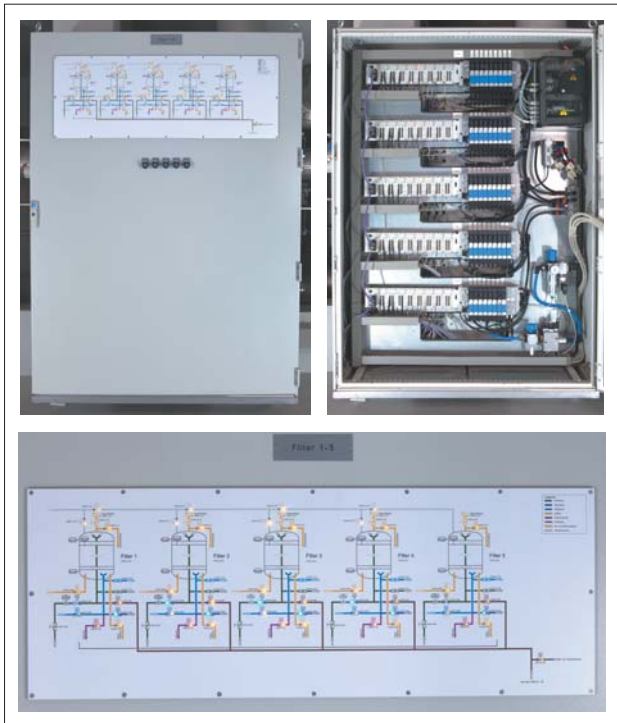
Ilustracja 5. Wyspa zaworowa w szafce sterowniczej ze schematem instalacji
