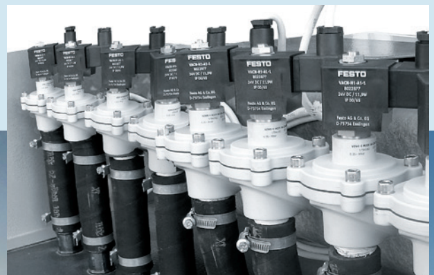
Het pulsventiel VZWE wordt tussen persluchtreservoir en buisventielen gemonteerd om het stof op de filters met perslucht af te schudden.
