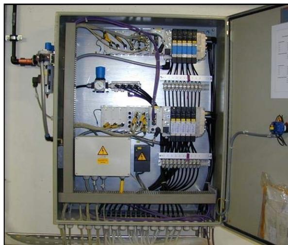
Abbildung 10: Schaltschrank mit Ventilinsel.
