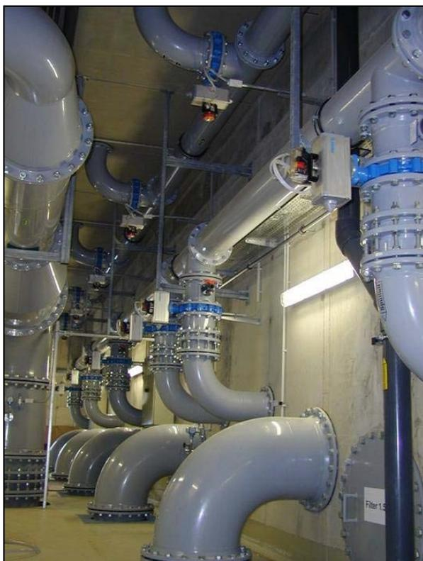
Abbildung 8: Rohr Keller in einer Wasseraufbereitungsanlage.
