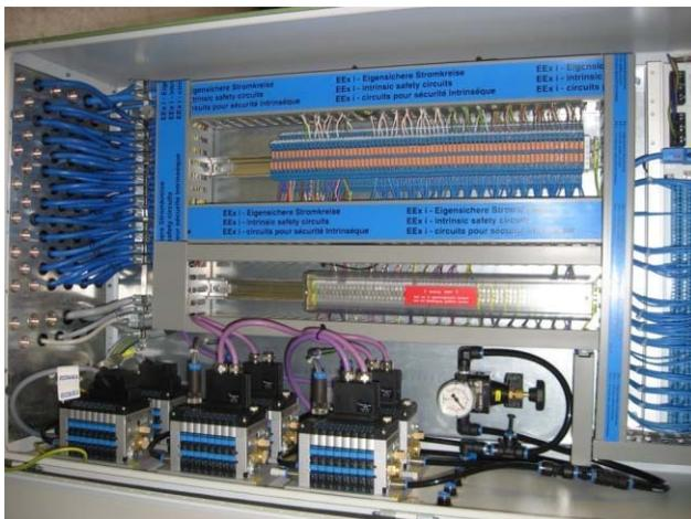
Abbildung 14: Ventilinselschrank in ATEX Zone 2 mit Ventilen für die PLT Schutzeinrichtung.
