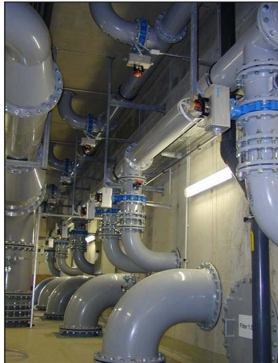
Figure 8 : cave de tuyauterie dans une station d'épuration.
