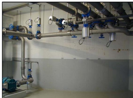
Figure 9 : cave de tuyauterie dans une usine de traitement des eaux.
