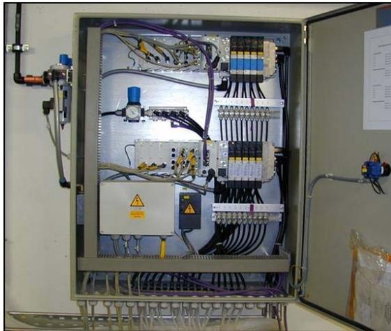
Figure 10 : armoire de commande avec terminal de distributeurs.
