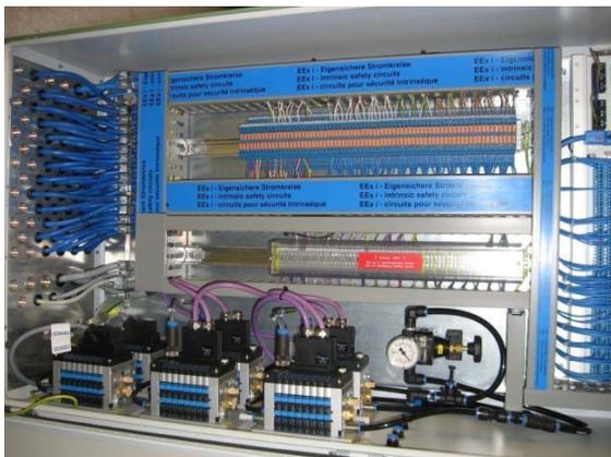
Figure 14 : armoire de terminaux en zone ATEX 2 avec distributeurs pour le dispositif de protection PLT.
