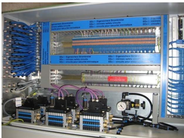
Figura 14: armário do terminal de válvulas na ATEX Zona 2 com válvulas para dispositivo de proteção PLT.
