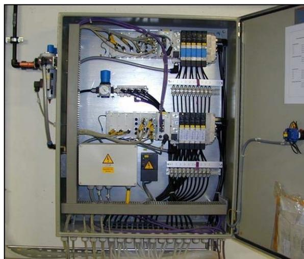
Figura 10: painéis de comando com terminal de válvulas.
