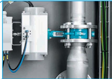
**Zuverlässig geregelt:** vollautomatisierte Absperrklappe KVZA von Festo.
