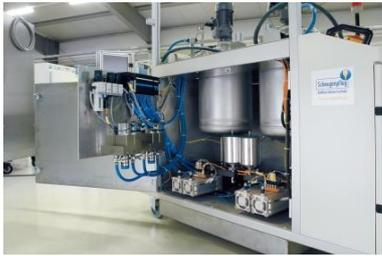
Abbildung 7 Ventilinsel in Schaltschrank
