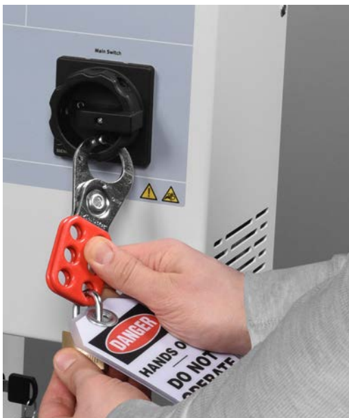
Figura 8: Instalación de un cerrojo de bloqueo, un candado y una etiqueta.
