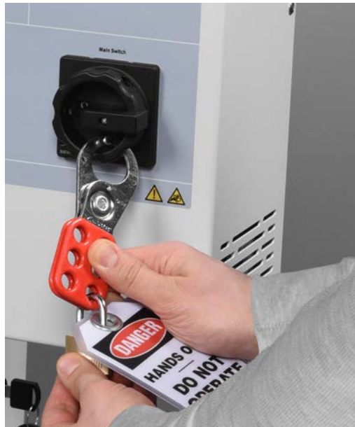
Figura 36: Dispositivo de bloqueo y etiquetado en un interruptor eléctrico.
