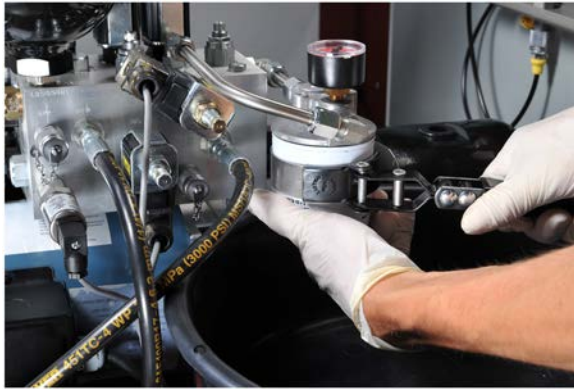
Figura 65: Extracción del filtro de aceite.
