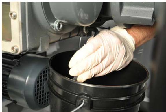
Figura 60: Extracción del tapón de drenaje.
