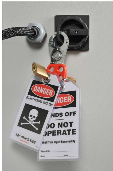
Figura 38: Instalación del cerrojo de bloqueo, los candados y las etiquetas.
