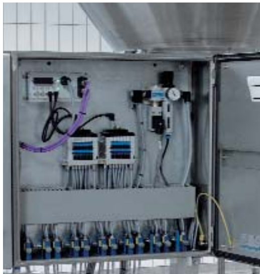
Una típica fábrica de cerveza de la industria híbrida con automatización de procesos con terminales de válvulas CPV del bus de campo en el depósito de fermentación de cerveza.
