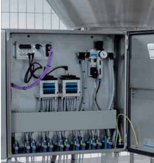
Klassische Hybridindustrie-Brauerei: Prozessautomation mit CPV Feldbus- ventilinseln im Biergärkeller.
