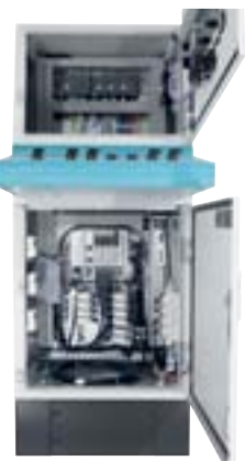
Réalisation d'armoires de commande sur mesure, en consultation avec le constructeur d'usine de traitement d'eau et l'exploitant
