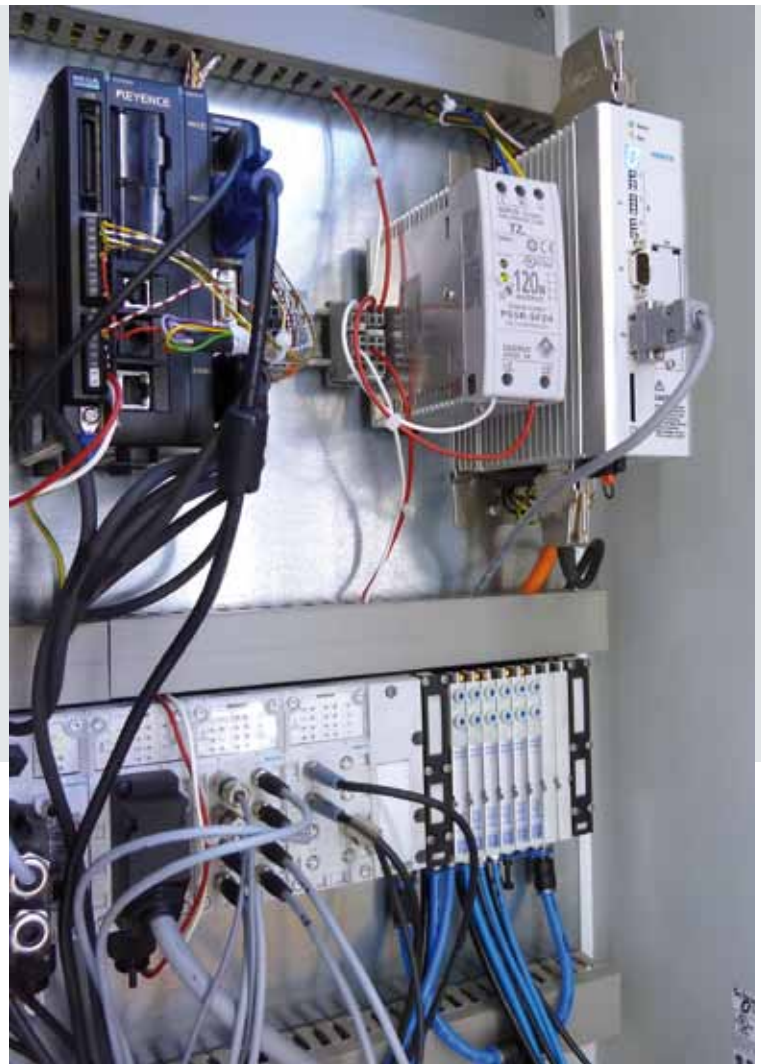
CPX/MPA-Ventilinselkombination mit integrierter Steuerung CEC im Zusammenspiel mit dem Motorcontroller CMMS.
