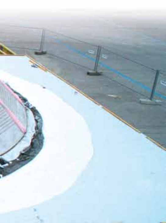
Freigeformte Betonschale – deutlich zu erkennen: die Pneus zwischen den einzelnen Segmenten.
