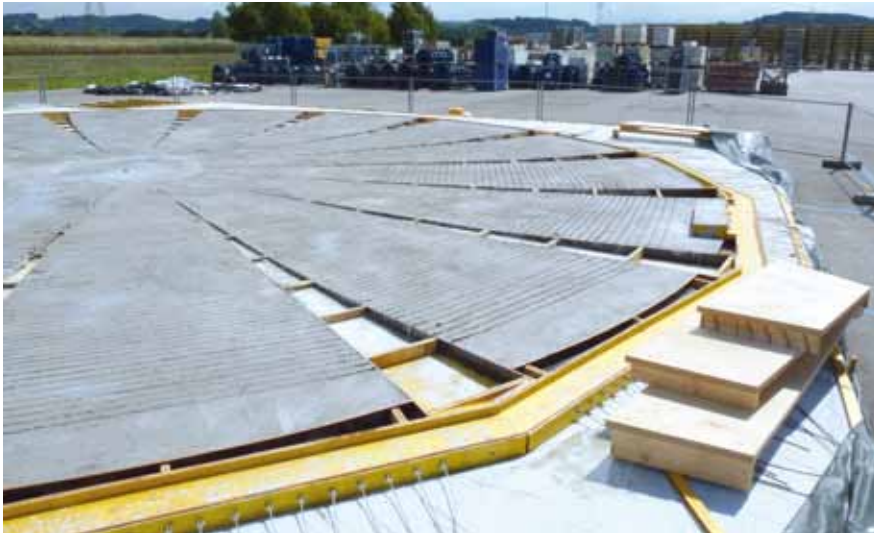
Fertig betonierte Platte mit eingedrückten Sollbruchstellen.
