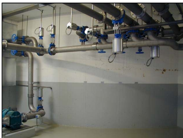
Fig. 9: Tubos tendidos en la planta inferior de una central de tratamiento de aguas residuales.
