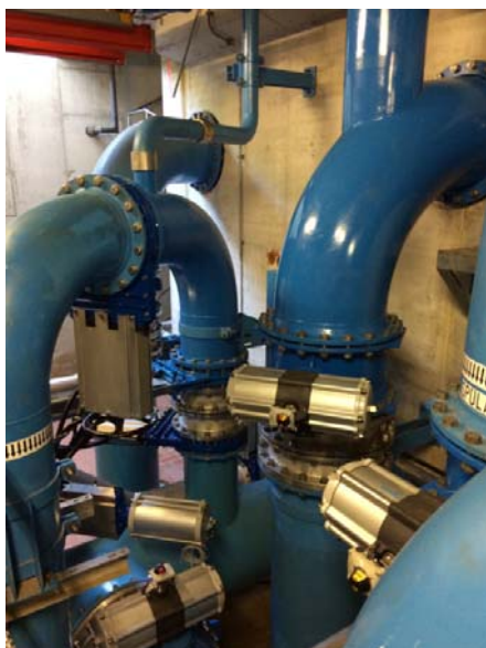
Abb. 1: Armaturen mit pneumatischen Antrieben Typ DAPS und DLP
