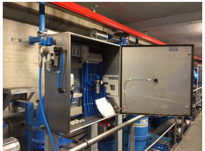
Abb. 3: Ventilinselschrank CPX-VTSA
