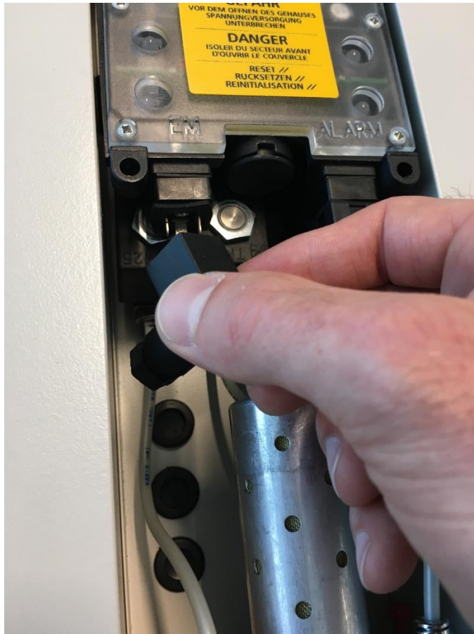
Abbildung 7 : Auslieferungszustand PDAD: Auf EM- Kontakt sitzt DIN- Stecker mit vorinstallierter Brücke
