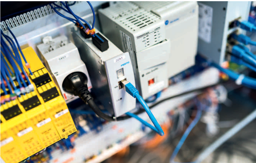
Klein, aber fein: Die Steuerung CMMO steuert den elektrischen Zylinder EPCO an, verbunden über IO-Link.
