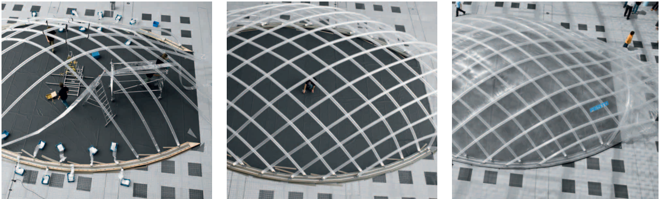
Selbstaufrichtende Pneus: Schneller Aufbau ohne Hilfskonstruktion
