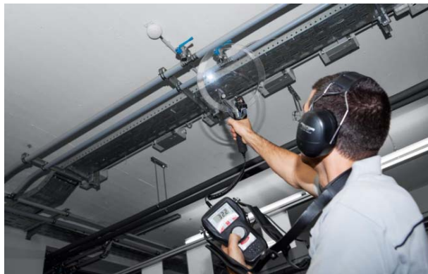
Abbildung 10: Ortung von Leckagen in der Druckluftverteilung
