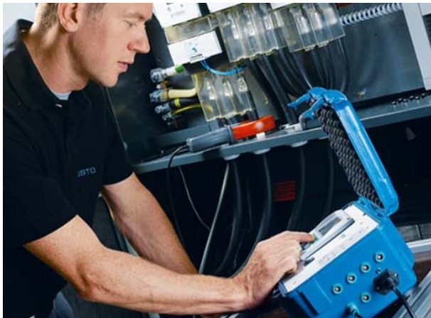
Abbildung 6: Energieanalyse der Drucklufterzeugung
